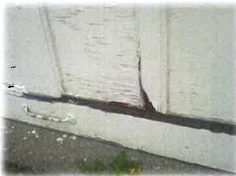
Bilde 19: Inngangsdør og roteskader garasjeport
